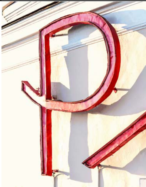
Гибкий неон закреплен внутри букв таким образом, чтобы он не провисал при нагреве летом.
